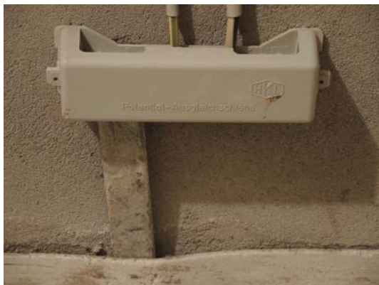
Bild 10: An der »Potential-Ausgleichsschiene« treffen sich ...
